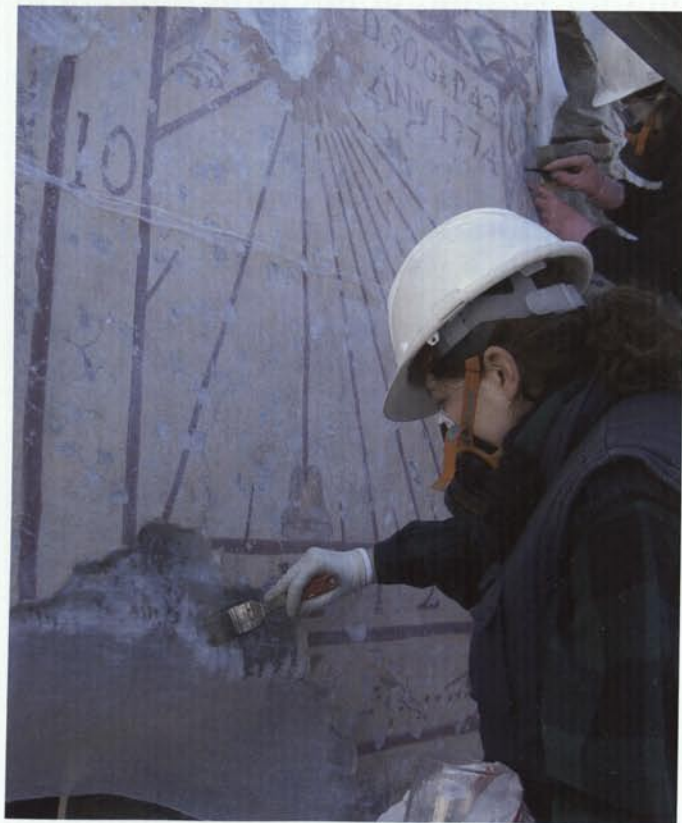
8. Procés d'adhesió a la pintura mural de les gases de cotó, mitjançant una dissolució de resina acrílica (Paraloid® B-72) al 30% en toluè (Fotografia: Equip de restauració).
