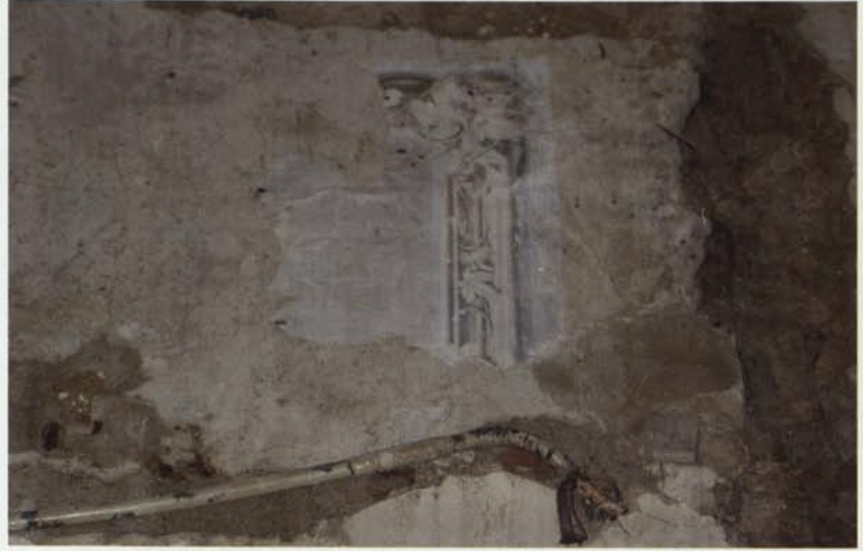
12. Fragment del paper pintat B, estampat amb un motiu vegetal imitant una cornisa, a la seva ubicació al mur d'una de les cambres de la planta principal de la masia (Fotografia: Equip de restauració).
