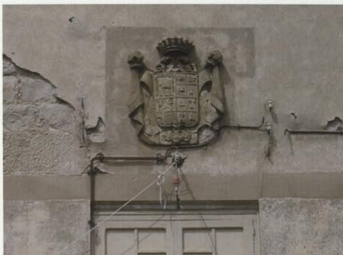
2. Detall de la façana principal amb l'escut de terracota a la seva ubicació, abans de la intervenció (Fotografia: Equip de restauració).
