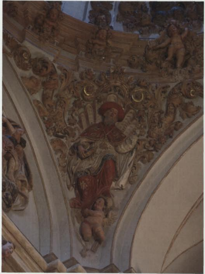
10. Pare de l'església realitzat en modelat directe, àngel i rocalla realitzats mitjançant motlles (Fotografia: Sandra Padrós Leiras).
