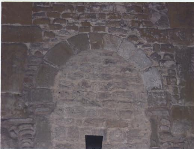
4. Detall d'una de les parets interiors de la cel·la on s'observa una de les obertures practicades en època medieval i que es varen mantenir durant la restauració (Fotografia: M. Mirambell).
