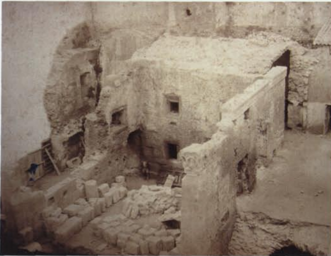
3. Fotografia del temple romà en el moment de la seva descoberta i després de ser "alliberat" de la seva carcassa medieval. S'observa l'amuntegament de carreus romans al costat dels murs de la cel·la, que va permetre aplicar la tècnica de l'anastilosi o recomposició amb elements originals dispersos o caiguts (Fotografia: Arxiu Episcopal de Vic).
