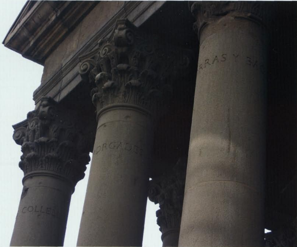
7. Detall de la part superior de les columnes de l'atri amb els cognoms dels prohoms vigatans gravats en el fust (Fotografia: M. Mirambell).
