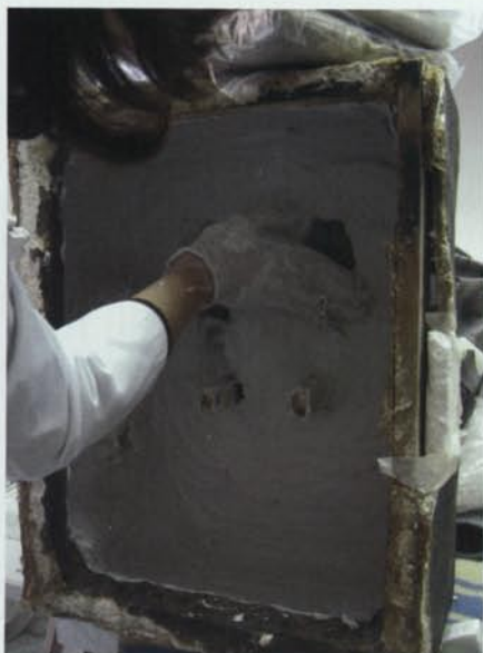
8. Procés de reforç de les parets de la peanya amb guix-escaiola (Fotografia: Equip de restauració).
