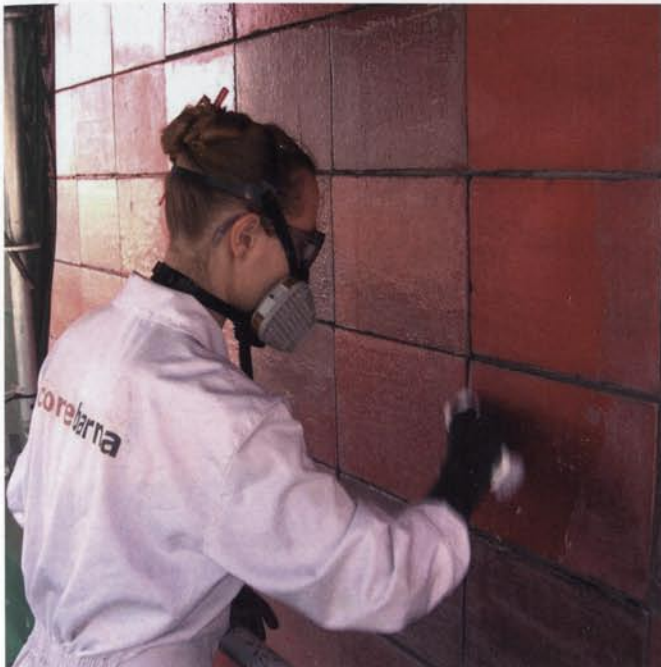
11. Eliminació química del vernís amb gel decapant (Fotografia: Pau Maynés Tolosa).
