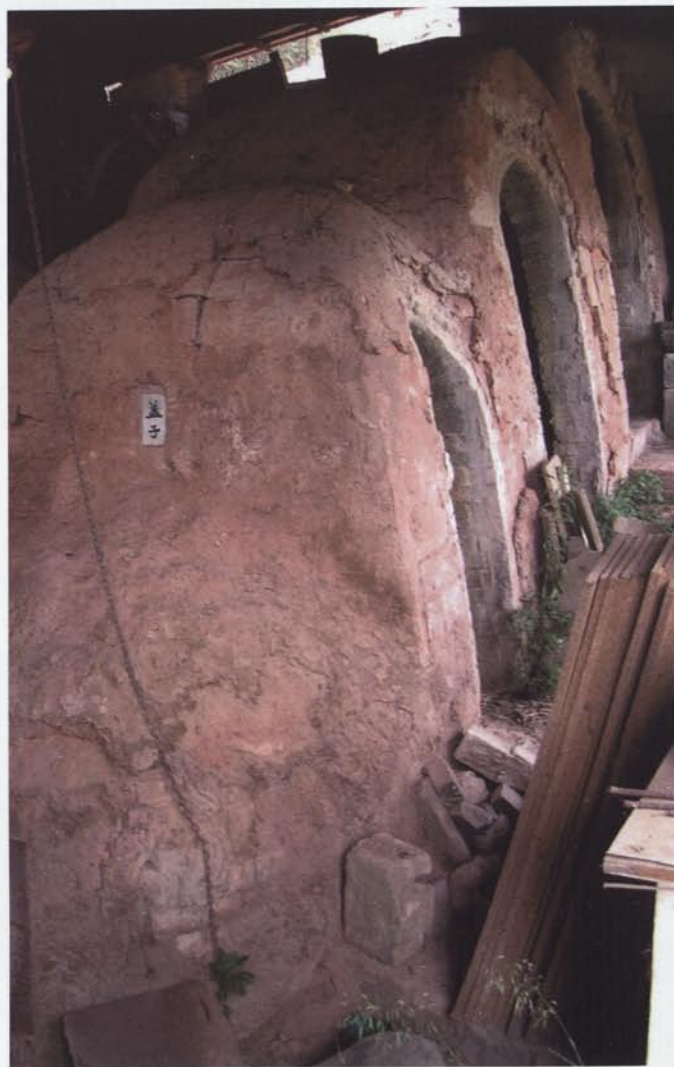
4. El forn dit "Mashiko", de tipus noborigama, a Gallifa (Fotografia: Pau Maynés Tolosa).
