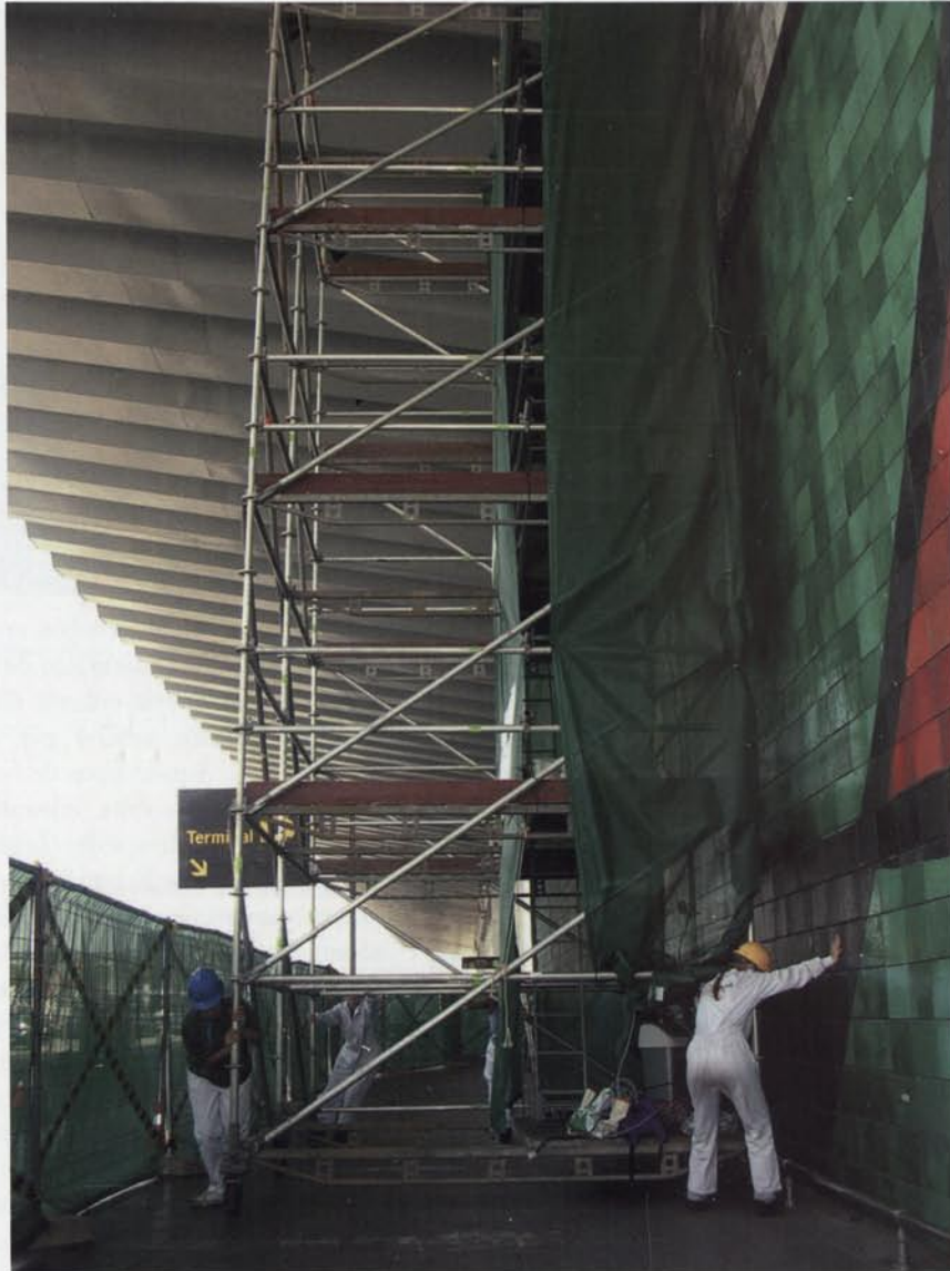
2. Desplaçament de la bastida (Fotografia: Pau Maynés Tolosa).
