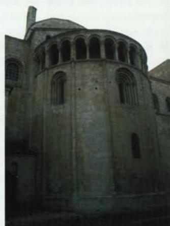
2. Catedral de la Seu d'Urgell, part posterior. S'observen zones amb recobriments taronges (les més rentades) i negres (les més protegides).
