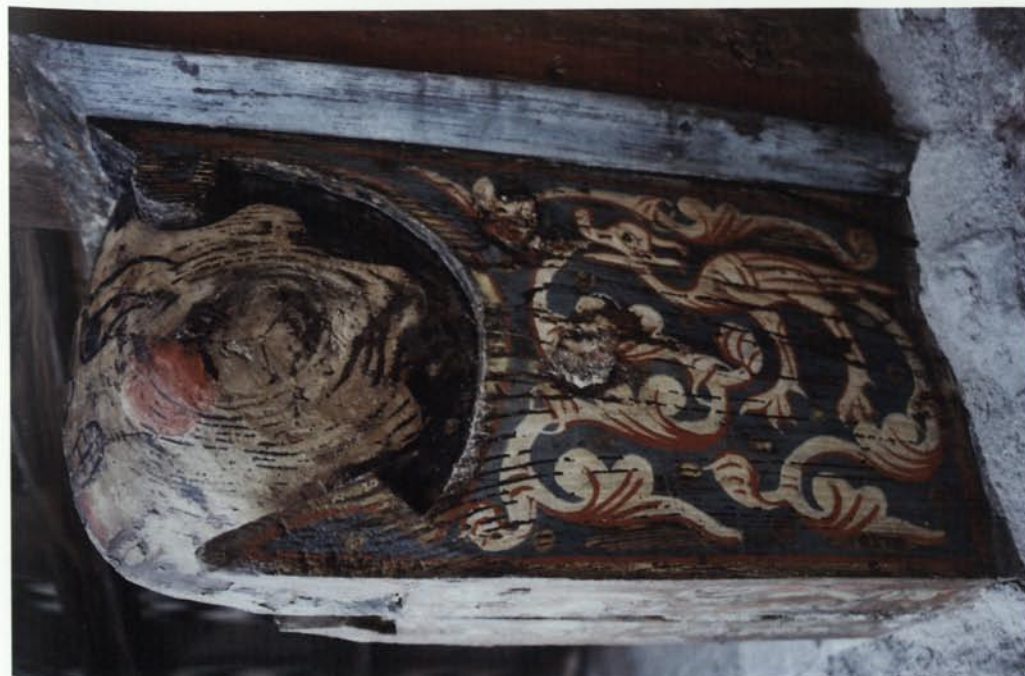
Ménsula 5 (biga 3), després del procés de consolidació i neteja (Fotografia: ESCRBCC).
