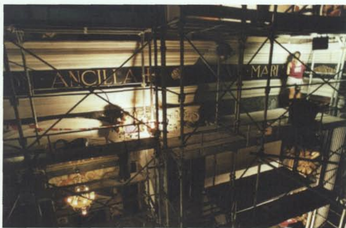
3. Pràctiques realitzades pels alumnes de les especialitats de Conservació i Restauració de Pintura i Escultura en la intervenció del teginat i de les pintures murals a la nau central del Santuari de Nostra Senyora del Sagrat Cor (Rosselló 175, Barcelona) (Fotografia: Cristina Thió).
