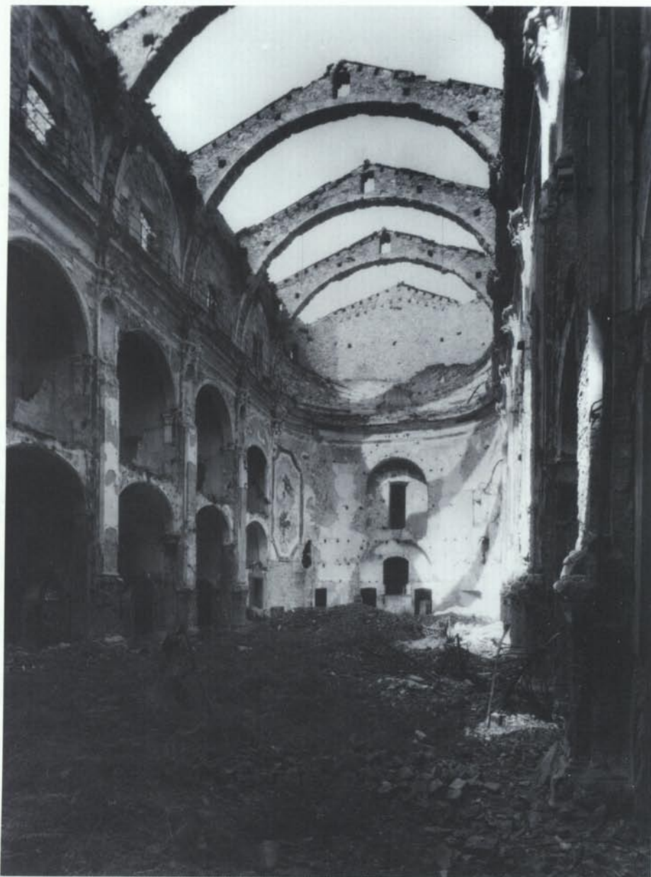
3. L'església del convent de Nostra Senyora de Betlem, a la Rambla de Barcelona, constituïa un dels millors conjunts d'art barroc existents a Catalunya. Incendiada el 19 de juliol de 1936, perdé tota la decoració interior i les voltes s'esfondraren, com es veu a la imatge (Fotografia: Institut Amatller d'Art Hispànic, Barcelona).
