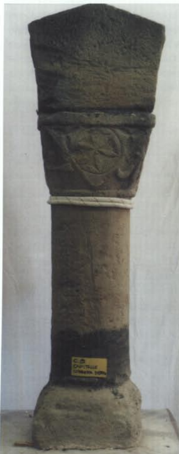
1. Columna de Corbera d'Ebre (segle XIII). S'observa l'aplicació barroera de ciment tipus Portland per tal de reparar una fractura (Fotografia: M. Artigau).
