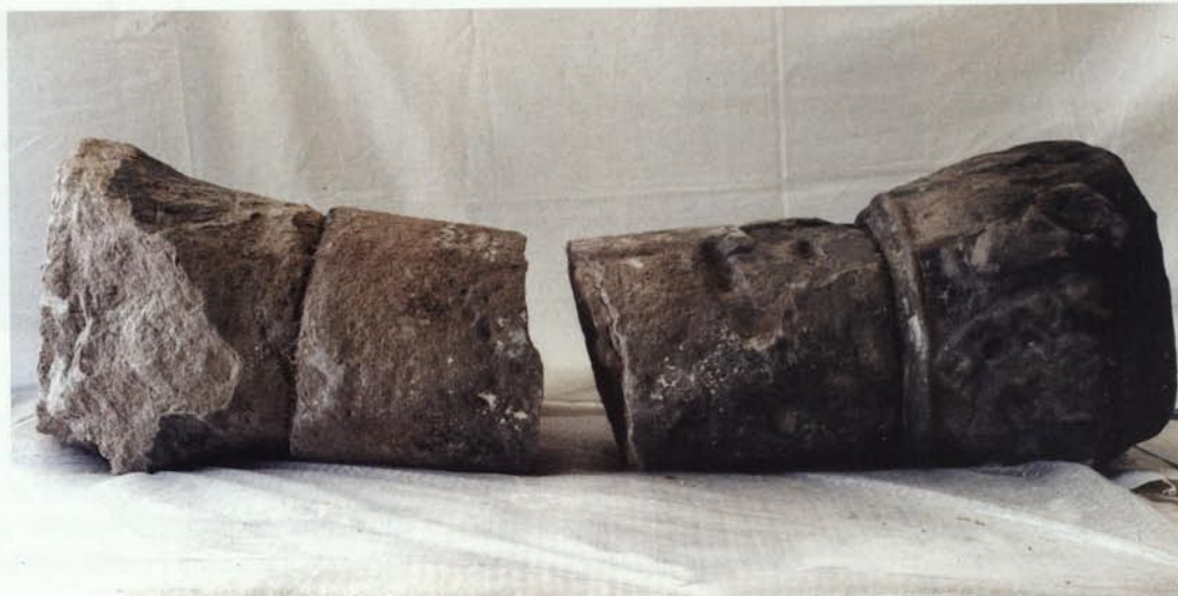
9. Columna corresponent al capitell núm. 5, abans de restaurar, on s'observa la fragmentació del fust i la manca parcial de suport petri de la base (Fotografia: ESCRBCB).
