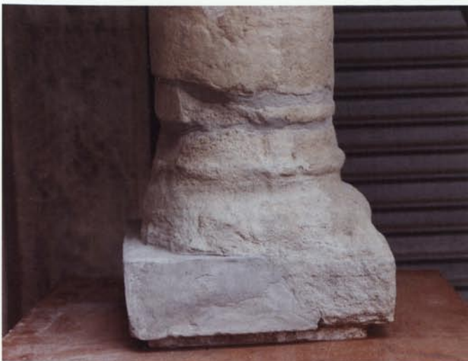
14. Base parcialment reintegrada i juntes segellades amb morter sintètic abans de l'abrassió amb glassfine per aconseguir una textura similar a la pedra del suport original (Fotografia: ESCRBC).
