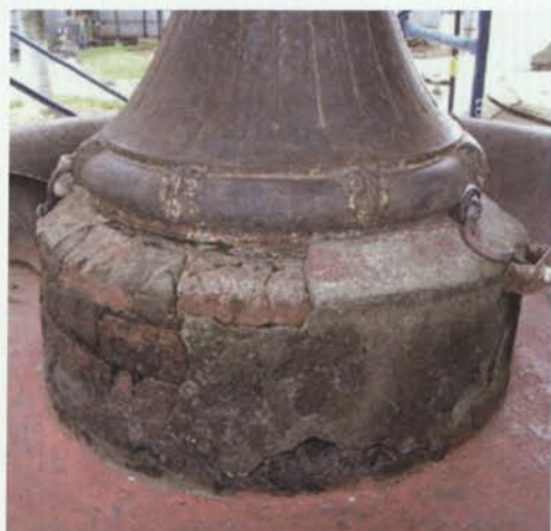
6 i 7. Procés de reintegració del suport d'unió (Fotografia: Montserrat Artigau).
