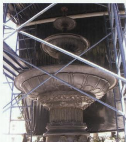
8. L'obra, un cop realitzada la inhibició del suport (Fotografia: Montserrat Artigau).
