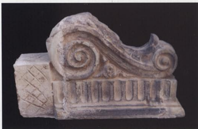
11 i 12. Mènula arquitectònica decorativa, abans i després de la intervenció. Aquesta peça va estar aplicada a la façana d'un edifici i presentava degradacions relacionades amb la seva exposició als agents atmosfèrics i a la contaminació (Fotografies: Montserrat Artigau).
