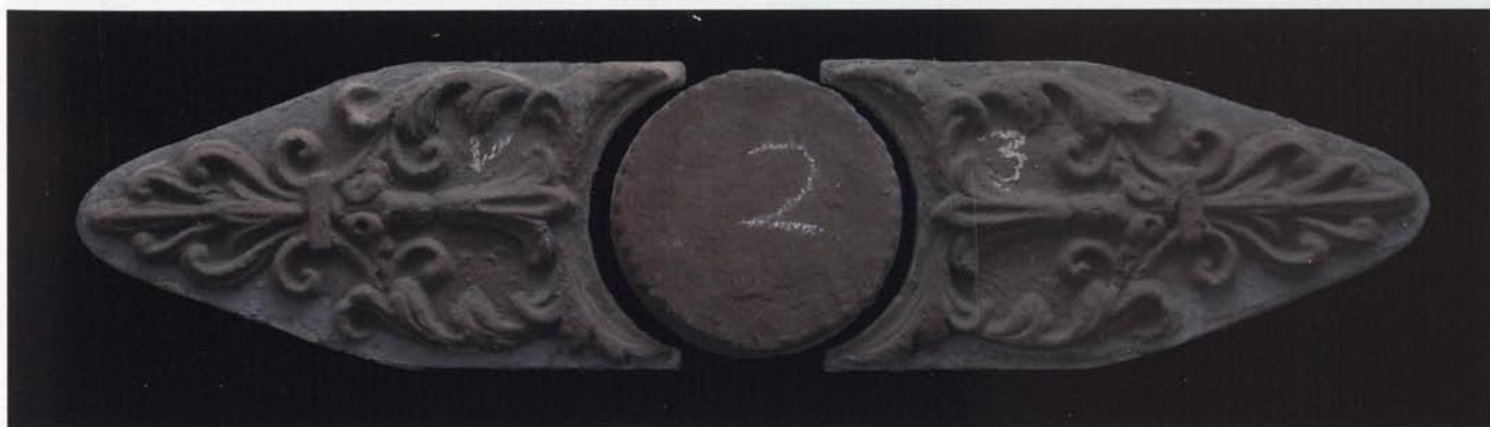
6 i 7. Placa de numeració decorativa, abans i després de la intervenció. S'observa com s'ha descobert la numeració, que es trobava totalment coberta pel morter (Fotografies: Montserrat Artigau).
