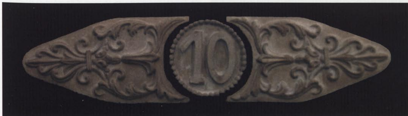
6 i 7. Placa de numeració decorativa, abans i després de la intervenció. S'observa com s'ha descobert la numeració, que es trobava totalment coberta pel morter (Fotografies: Montserrat Artigau).
