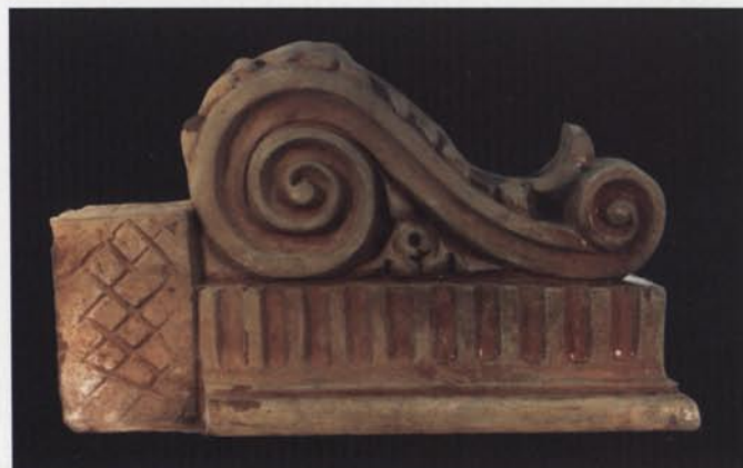
11 i 12. Mènula arquitectònica decorativa, abans i després de la intervenció. Aquesta peça va estar aplicada a la façana d'un edifici i presentava degradacions relacionades amb la seva exposició als agents atmosfèrics i a la contaminació (Fotografies: Montserrat Artigau).
