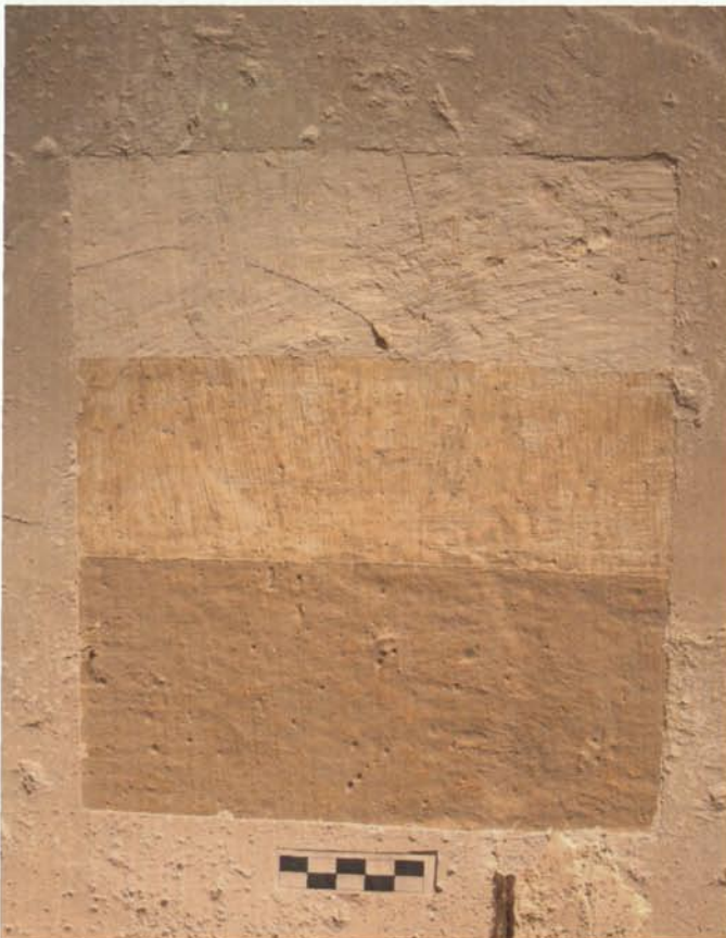
7. Testimoni d'algunes de les capes d'emblanquinat eliminades (Fotografia de les autores).
