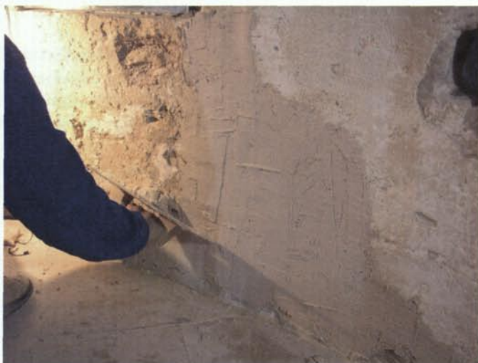
5. Aplicació de morter en una llacuna extensa amb els estris tradicionals (Fotografia de les autores).
