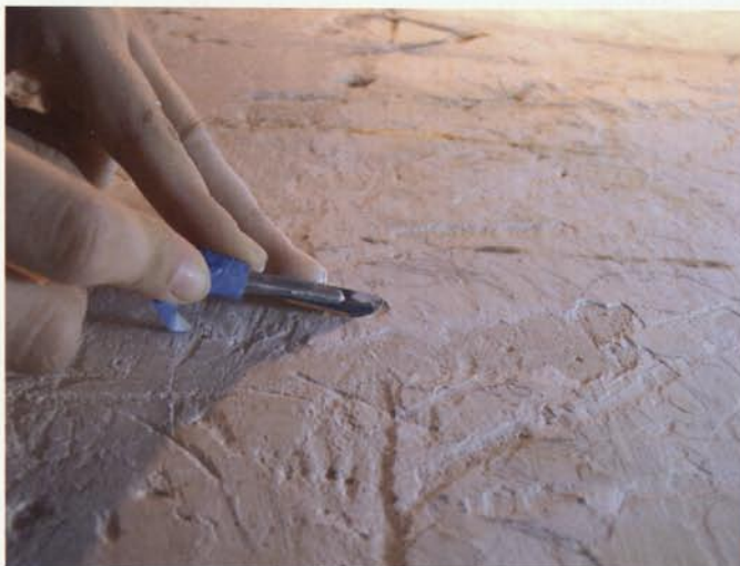
3. Detall de la neteja de la darrera capa d'emblanquinat (Fotografia de les autores).
