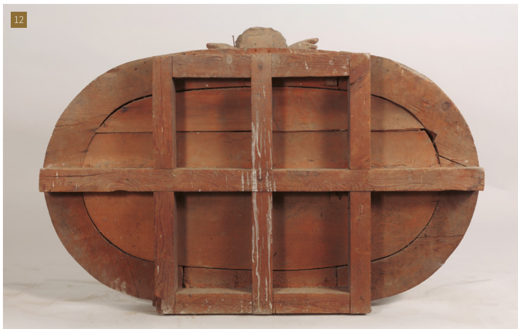
[16] Timpà el·líptic central, on s'observen els travessers estructurals i els llistons de fusta que el conformen (Fotografia: CRBMC).
