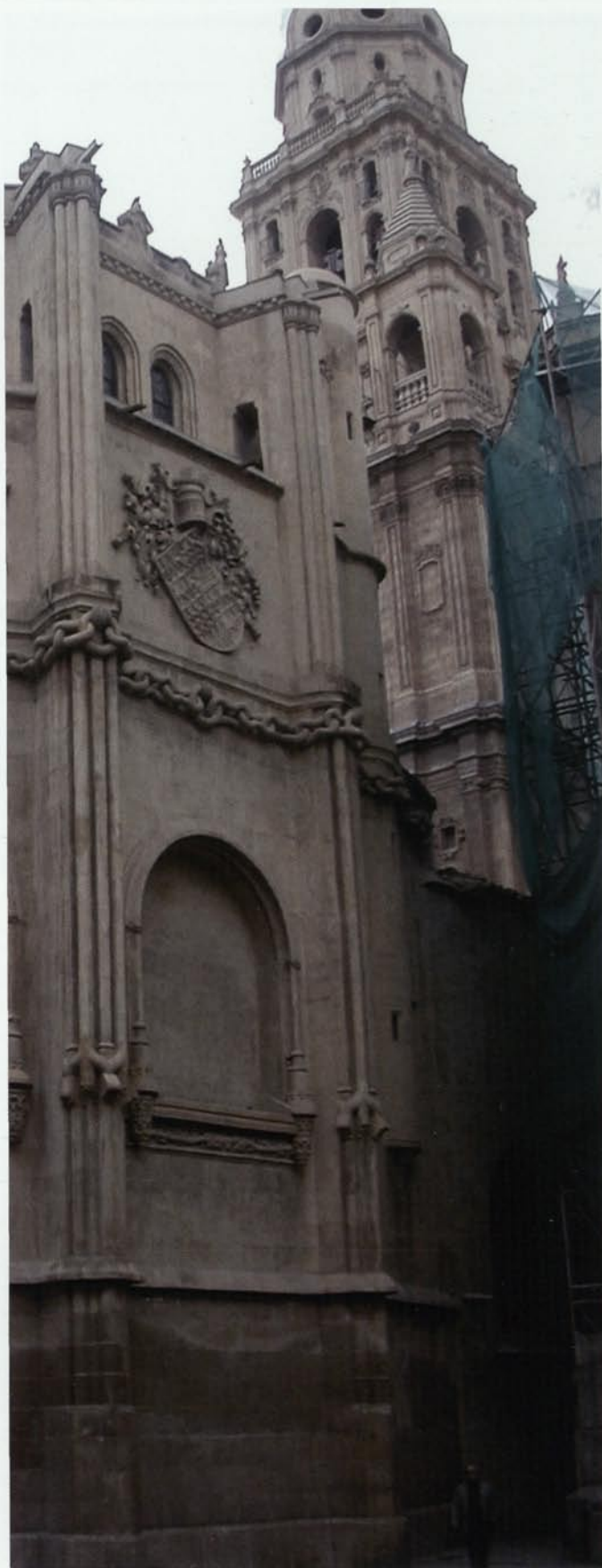
8. Vista de la torre de la catedral de Múrcia des de l'absis (Fotografia: Manuel Iglesias).
