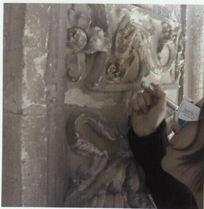
10. Procés de neteja en zones amb crosta negra a la torre de la catedral de Múrcia (Fotografia: Manuel Iglesias).
