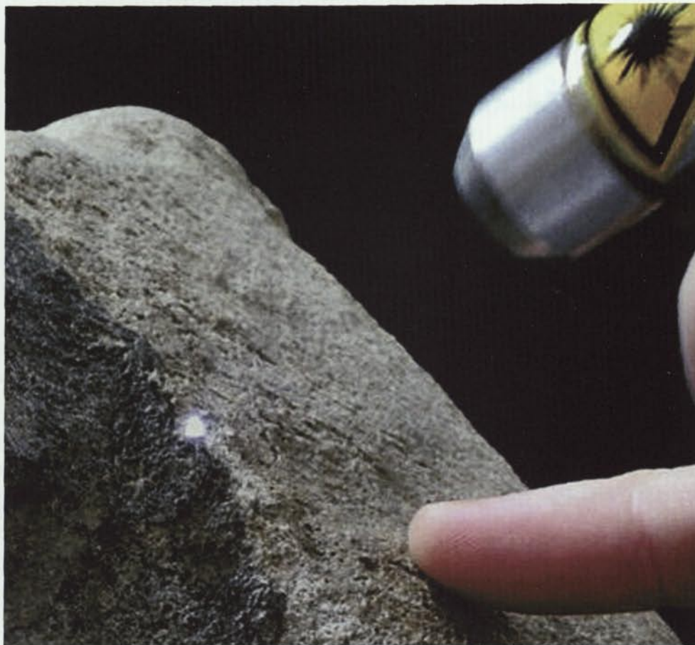
4. Neteja de crosta negra en material calcari arenitzat. Restauració de la creu de Santa Anna de Les Escaldes d'Andorra (Fotografia: Mireia Garcia Garcia-Cairó).
