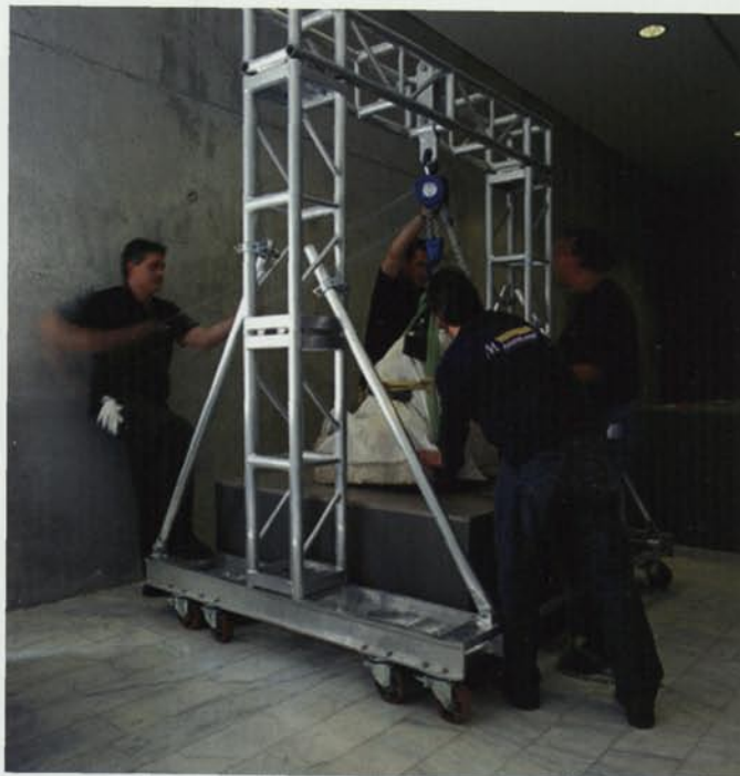
3. Instal·lació d'una peça pesada amb una grua de sala (Fotografia: Sergi Olivares).
