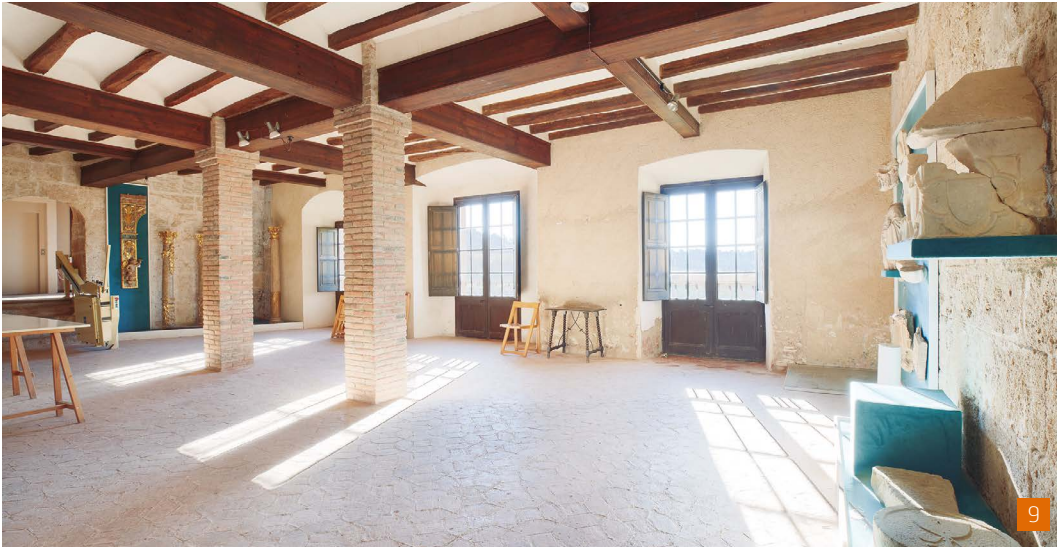
[9] Dipòsit 2, amb un índex d'emmagatzematge inferior a les seves capacitats.
