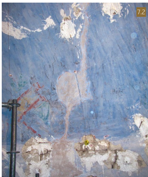
[6] Revers de la reproducció de les pintures. Sistema d'ancoratges de l'estructura al mur.
