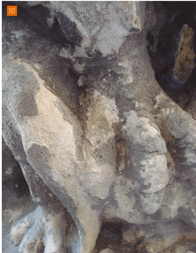
[10] Imatge de detall de la zona inferior de la gàrgola 1 amb presència de descamació de la crosta negra (Fotografia: E. Planells).
