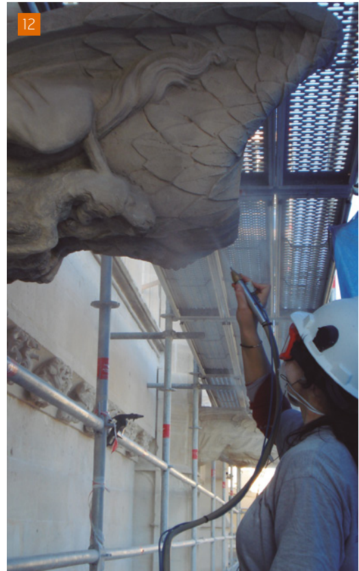
[11] Detall de cala de neteja mecànica amb microtorn per al rebax de la crosta negra.
