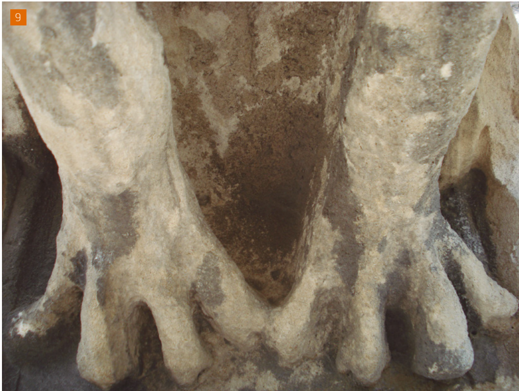
[9] Imatge de les extremitats anteriors de la gàrgola 10 amb una elevada presència de disgregació del suport (Fotografia: E. Planells).
