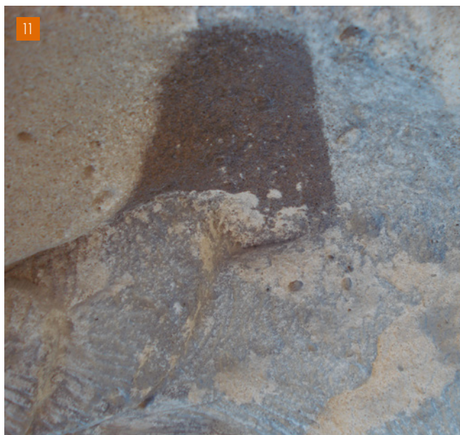
[10] Imatge de detall de la zona inferior de la gàrgola 1 amb presència de descamació de la crosta negra (Fotografia: E. Planells).
