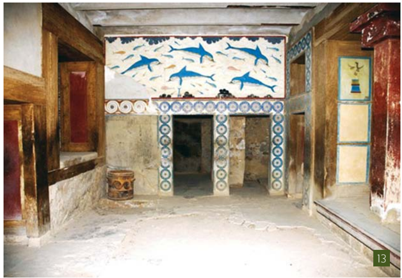
[13] Imatge actual de la Cambra, rèplica de la recreació visual (Arxiu del Metropolitan Museum de Nova York). Cal observar la degradació del paviment (l'original i el de ciment afegit) i de la pintura sobre formigó que intenta imitar la fusta. A l'esquerra es pot veure com la reconstrucció en formigó recolza sobre la base de pedra minoica.
