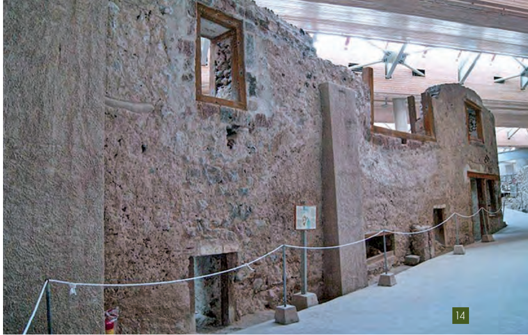
[14] Reconstrucció en formigó de portes i finestres, imitant la fusta original, i pilars de formigó externs per consolidar l'edifici (Fotografia: Klearchos Kapoutsis).
