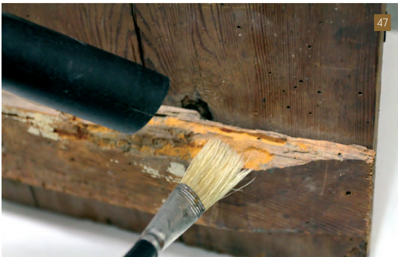
[47] Neteja mecànica en sec d'un dels travessers en què podem veure l'atac sever d'insectes xilòfags (Fotografia: Voravit Roonthiva).
