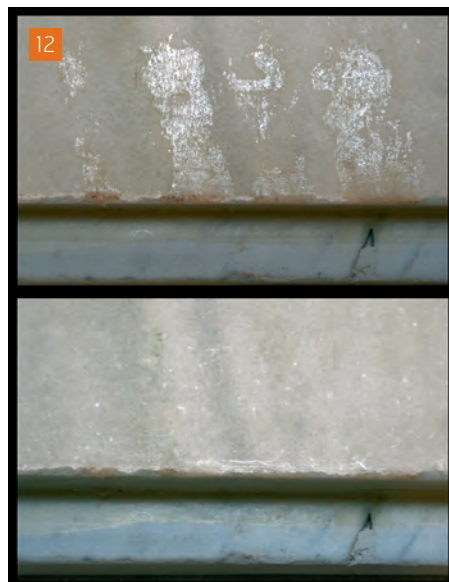
[11] Detall de les partícules despreses en la descohesió del marbre.
