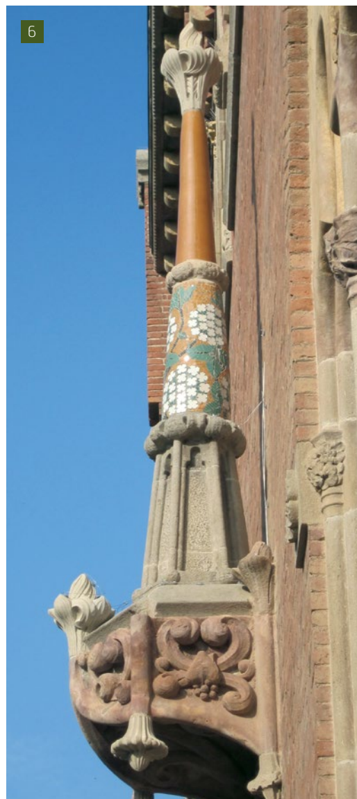
[6] Pinnacle d'angle, tram E P8 (Fotografia: Àbac).
