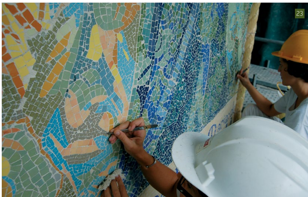
[23] Neteja després de l'aplicació del nou morter de junt, tram R M15 (Fotografia: Àbac).
