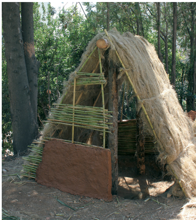
[5] Cabana grubenhaus en procés de construcció dins del recinte de l'ESCRBC. Es pot observar l'entramat de canyís de les parets, sobre el que posteriorment es va aplicar un morter d'argila i palla (Fotografia: Sílvia Marín).
