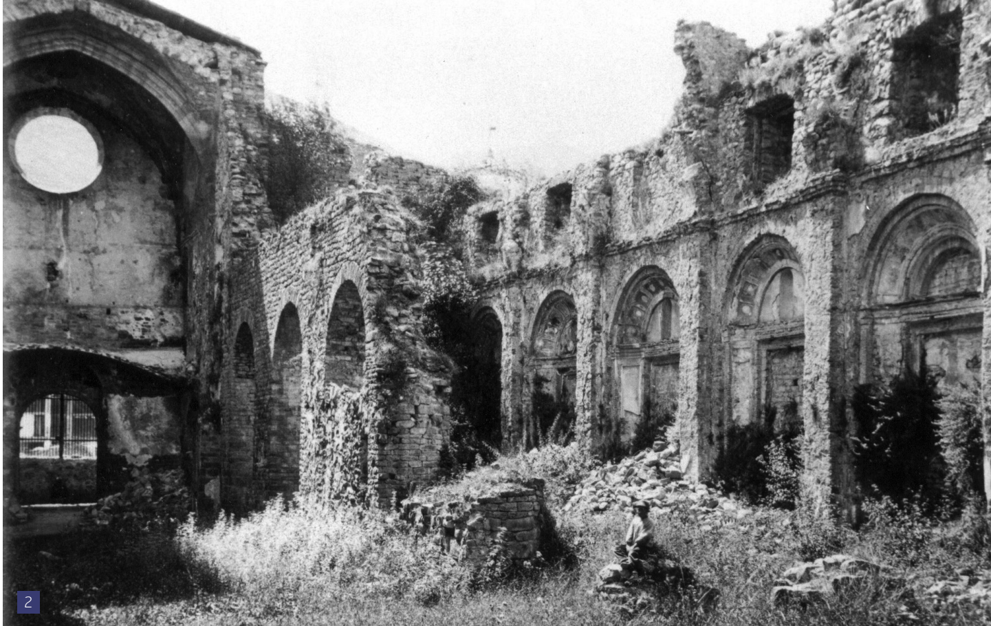
Fotografia de la nau en direcció sud, de l'any 1879 (Fotografia: Marc Sala).
