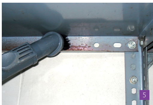
Aspiració de les estructures, prestatgeries i parets (Fotografia: Berta Blasi).
