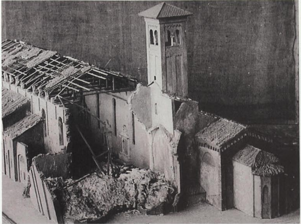
4. Maqueta de l'església dels Eremitani després del bombardeig (Fotografia: Archivio fotografico Soprintendenza per i beni architettonici del Veneto orientale).
